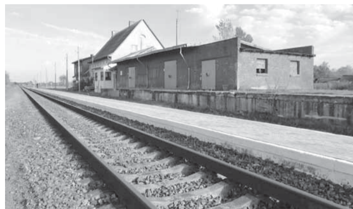
Вокзал и привокзальные склады.
