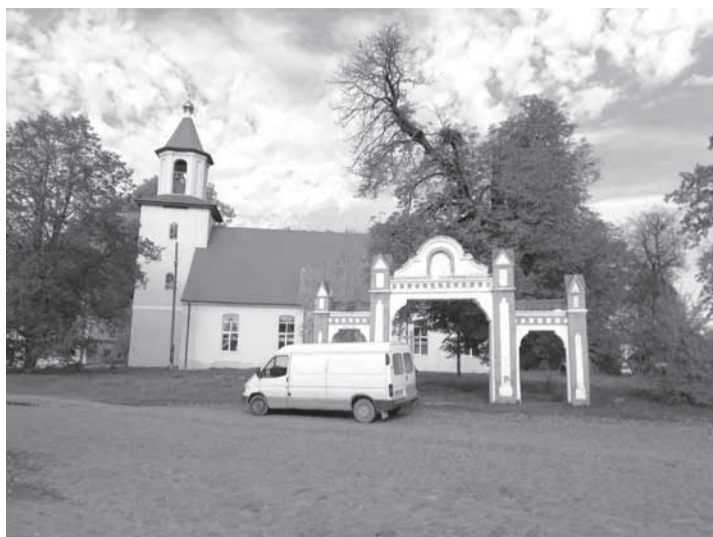
Лютеранская, теперь православная церковь.
